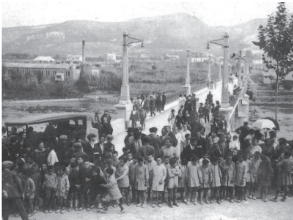
PONT DE SANT VICENÇ. ANY 1929. FAMÍLIA ANDRÉS CANAL: Es veu com eren els primers fanals que es van instal·lar al Pont.
